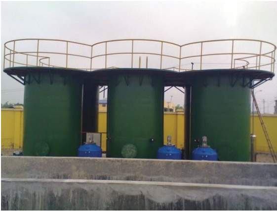
Hệ thống ABNR công suất 500m 3 /ngày được GREE áp dụng thành công tại nhà máy chế biến thủy sản Holland Seafood
